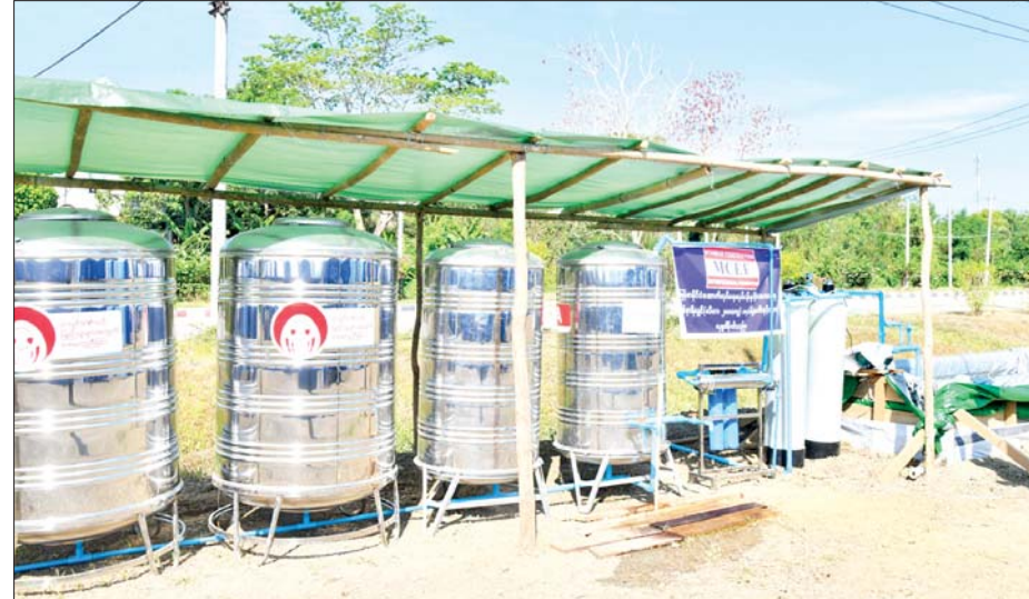
ဝဏ္ဏသိဒ္ဓိရပ်ကွက်၌ တည်ဆောက်ထားသည့် ယာယီတည်းခိုရေးစခန်းတွင် ရေသန့်စက်တည်ဆောက်ထားရှိမှုကို တွေ့မြင်ရစဉ်။
