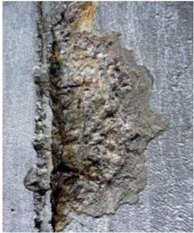
Рисунок 1. Коррозия бетона
