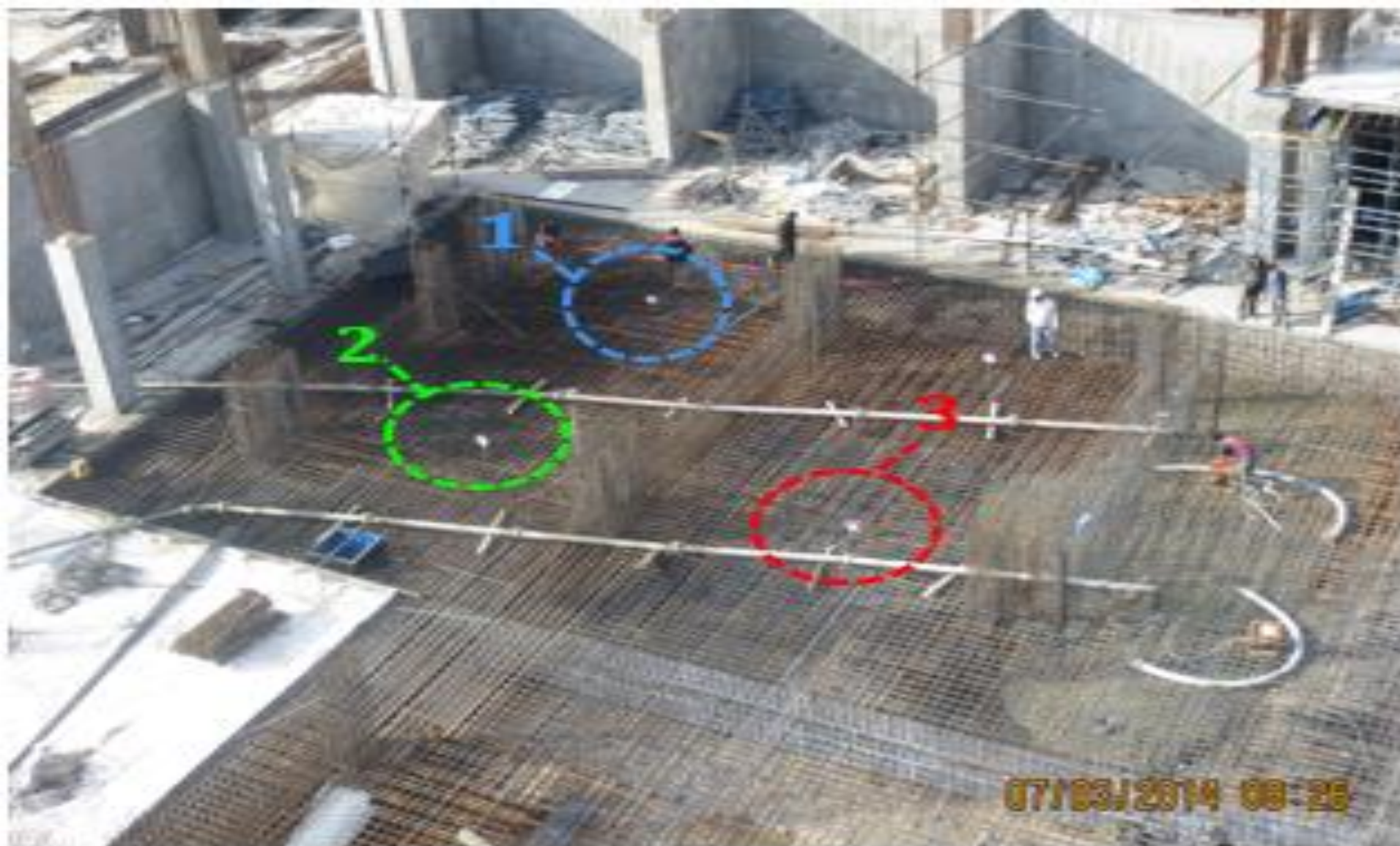
شکل 3- محل جانمایی سنسورهای حرارتی
