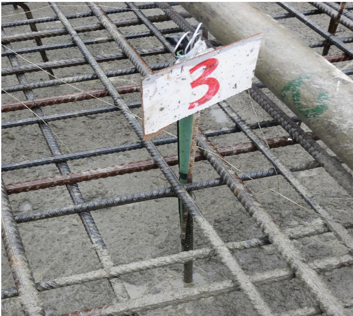
شماره گذاری ایستگاه های اندازه گیری دمای فونداسیون
