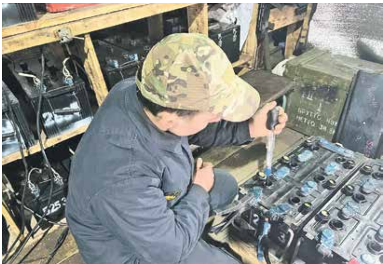
Проверка плотности заряда.
