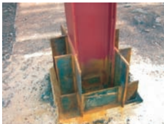
شکل ۸-۲۱- نمونه‌ی اتصال گیردار پای ستون با ورق سفت‌کننده
