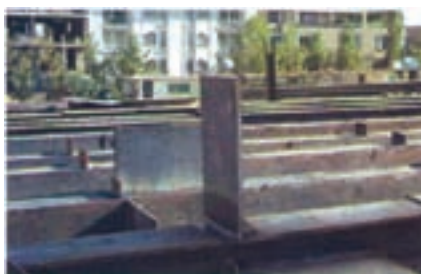
نصب ورق زیرسری روی ستون در کارگاه
