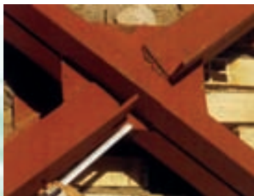
گسیختگی در اثر طول جوش کم عضو مهاري به ورق اتصال
