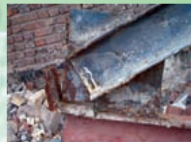
اتصال نامناسب تیر موجب فرو ریختن سقف شده است.
