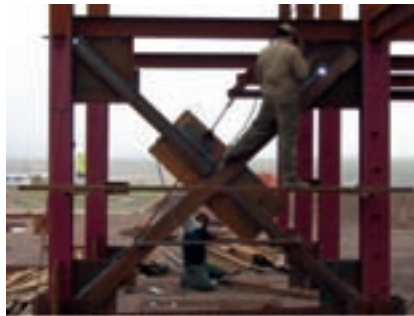
شکل ۸-۱۷- نمونه‌ای اجرای اتصالات مهاربندی
