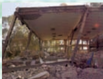
اتصال نامناسب تیر موجب فرو ریختن سقف شده است.
