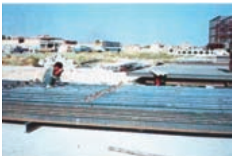
جوشکاری نبشی نشیمن روی زمین
