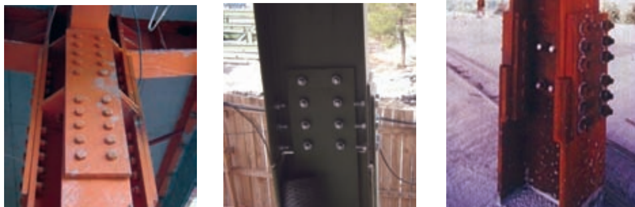
شکل ۸-۲۵- اتصال ستون به ستون بصورت پیچ و مهره‌ای
