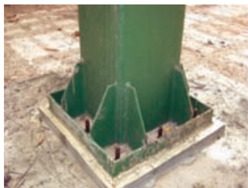
شکل ۸-۲۱- نمونه‌ی اتصال گیردار پای ستون با ورق سفت‌کننده
