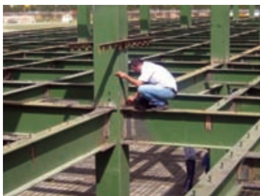
اتصال اعضای قاب در اسکلت فولادی
