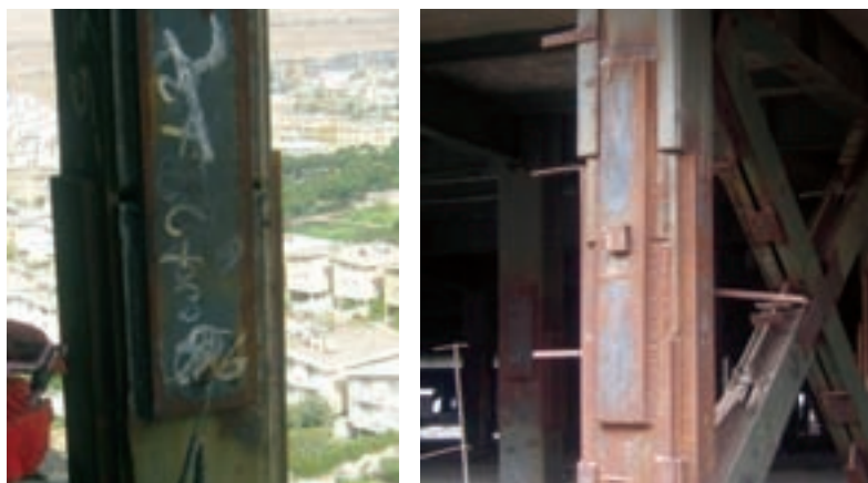
شکل ۸-۲۴- وصله جوشی ستون جعبه‌ای
