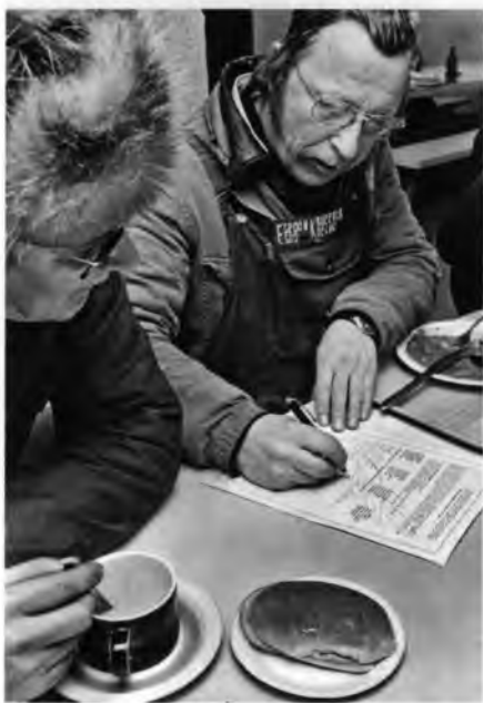
Rauhantyötä Jorvin työmaalla.
