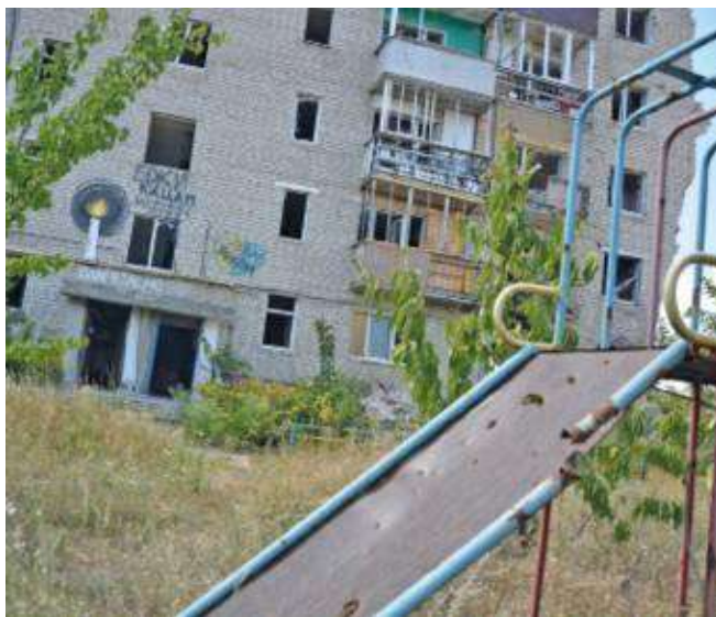
Разрушения на востоке Украины (год 2024)
