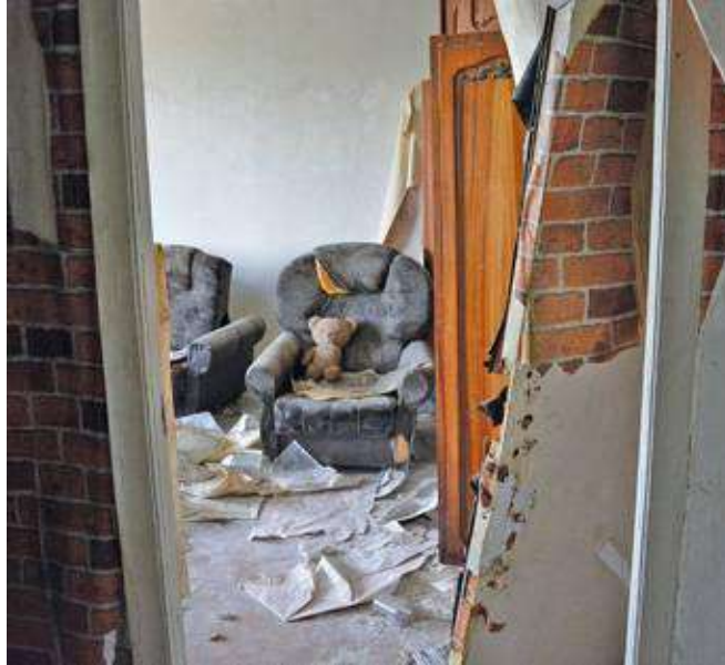
Разрушенный дом на востоке Украины (2024 год)
