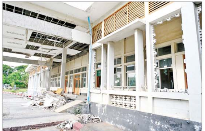
နေပြည်တော် ပြည်သူ့ဆေးရုံကြီး (ခုတင်-၃၀၀)ရှိ ဆေးကုသဆောင်များ ငလျင်ဒဏ်ကြောင့် ထိခိုက်ပျက်စီးမှုကို တွေ့မြင်ရစဉ်။
