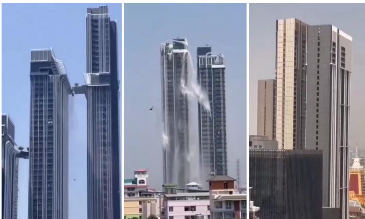
شکل ۳۱- برخورد آهسته با پیود بلند دو برج به همدیگر در بانکوک در اثر زلزله ۷.۷ میانمار
