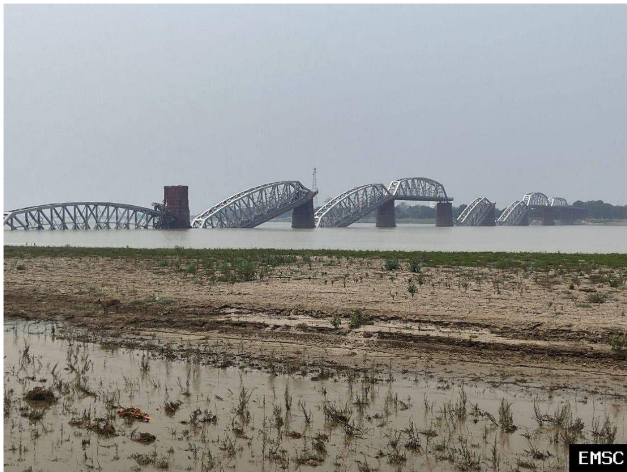
شکل ۲۷- فروریختن پل. گزارش شده که این پل Sagaing از رودخانه ایراودی عبور می‌کند.
