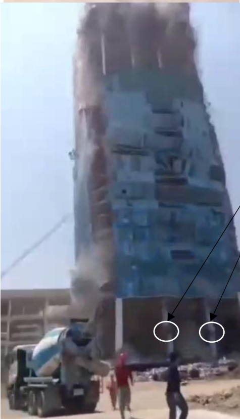
شکل ۳۵- شکل طبقه همکف و نقاط شکستگی در ستون‌ها در برج فرو ریخته بازار چاتاچوک بانکوک تایلند
