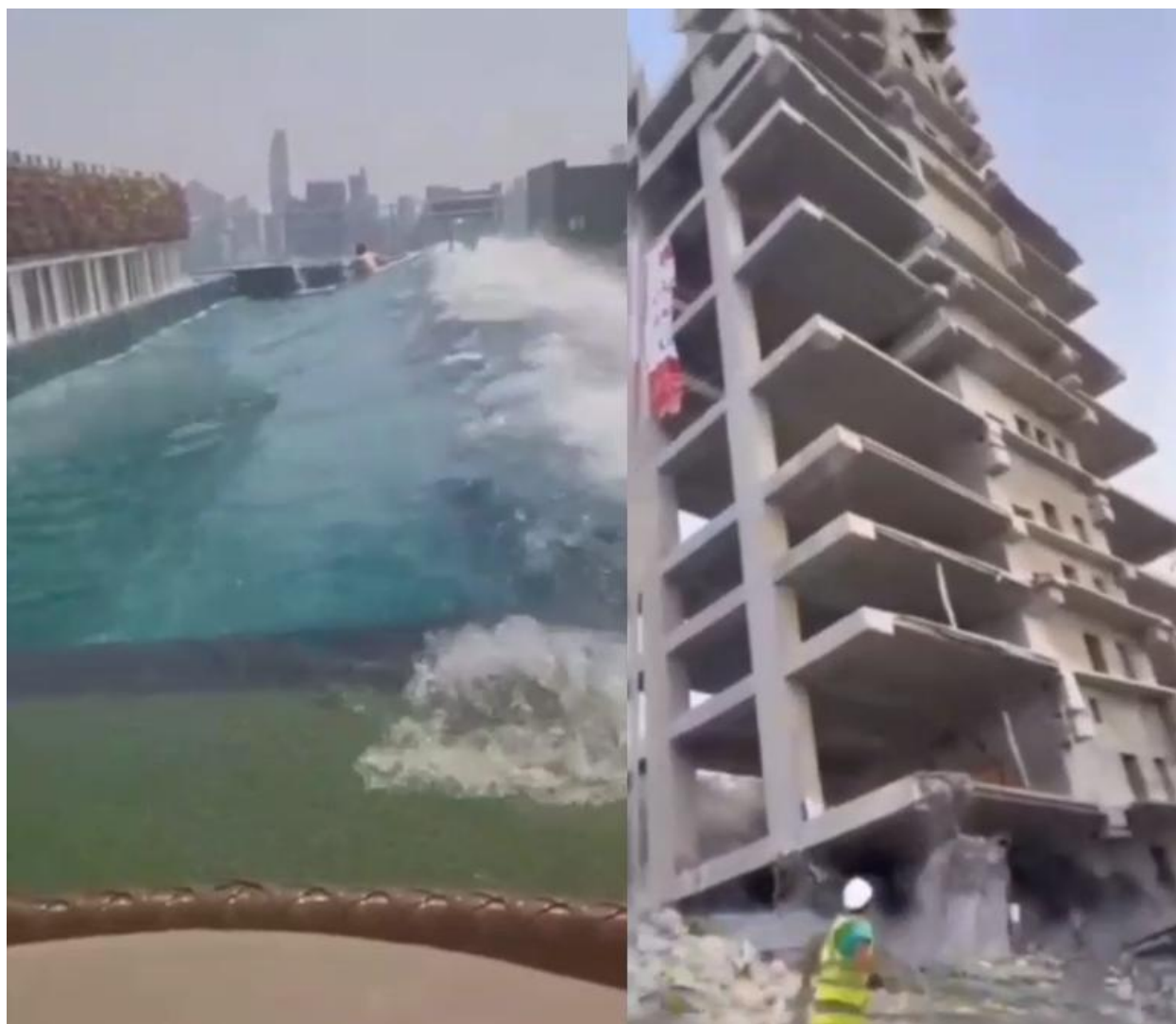
شکل ۳۳- متلاطم شدن آب استخر در پشت بام (عکس سمت چپ) و واژگونی ساختمان دیگر (عکس سمت راست)
