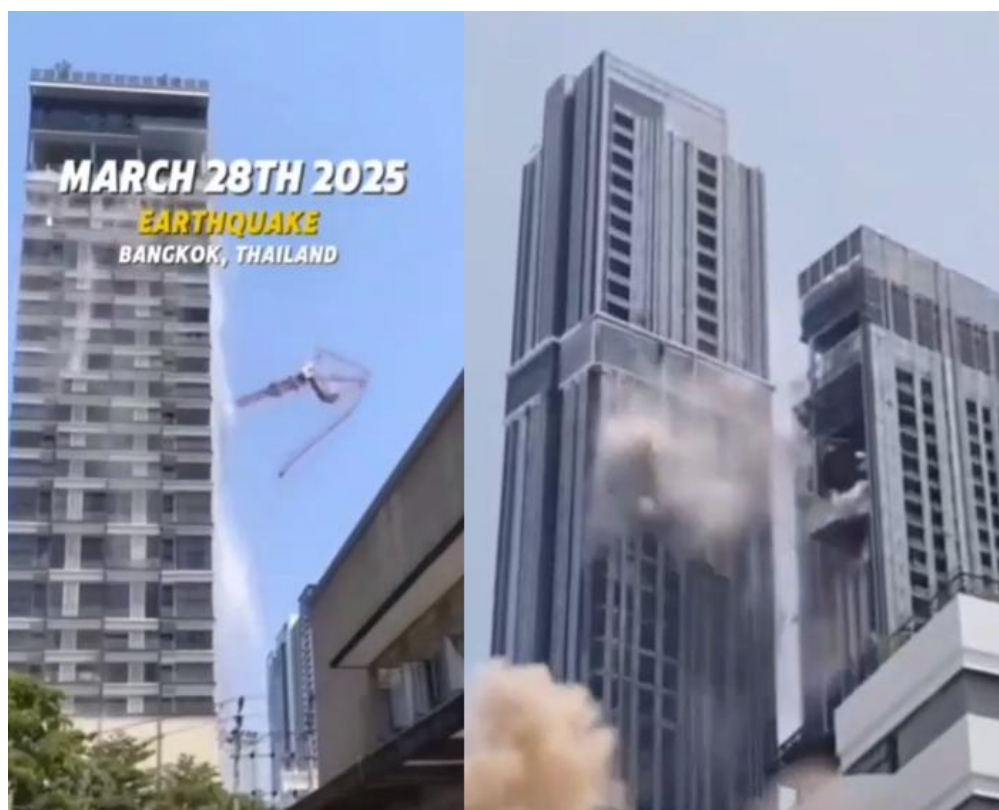
شکل ۳۲- آسیب به ساختمان در اثر برخورد به همدیگر و افتادن جرثقیل از ساختمان
