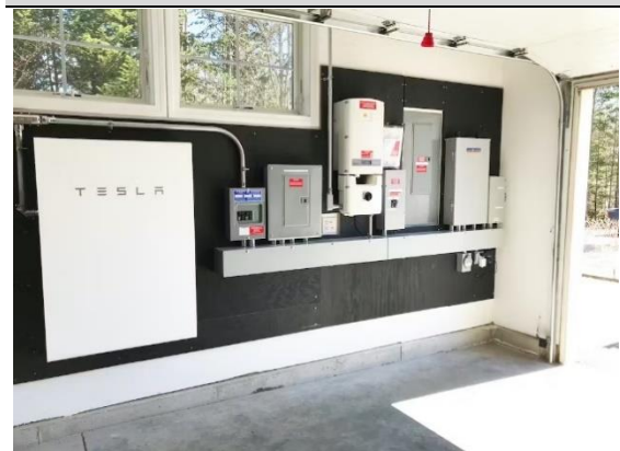
미국 가정집에 설치된 Tesla Powerwall
