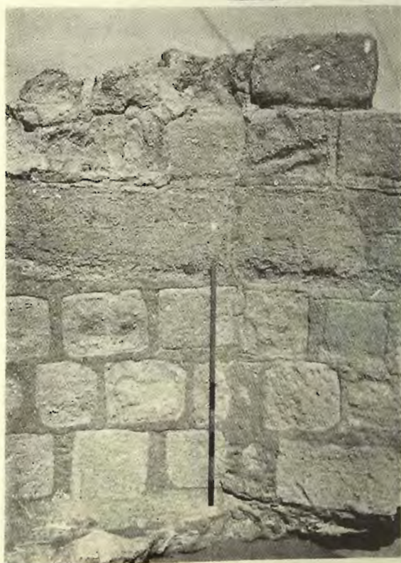
شکل ۶ - نمایش سنگهای بکاررفته در پایه سنگی سد قل بالا «جزیره قشم» (عکس از نگارنده)
